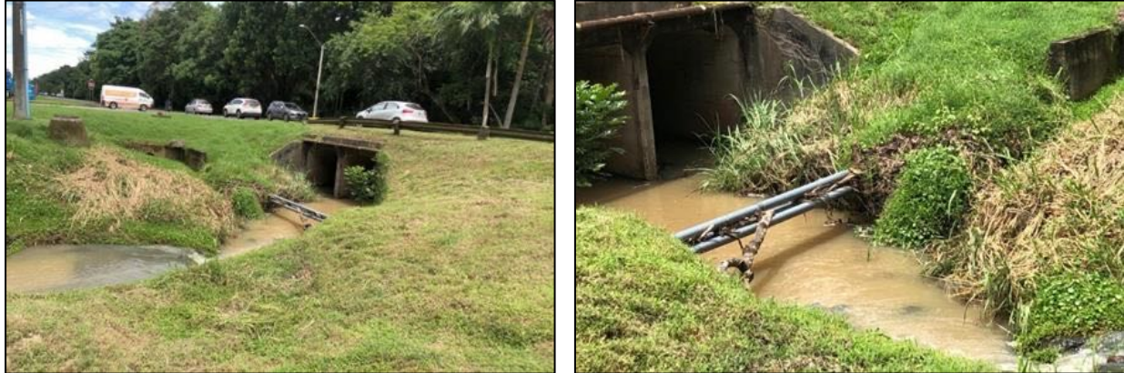
Figura N° 20. Alcantarilla de cruce del río Farfán en Howard
